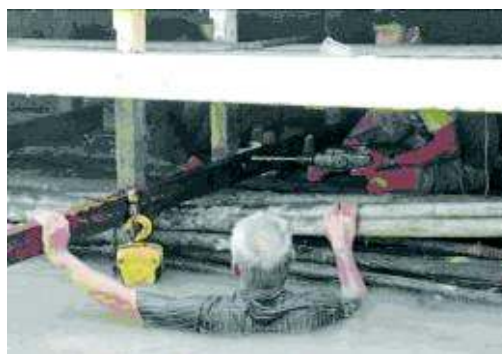
補修工事の様子
